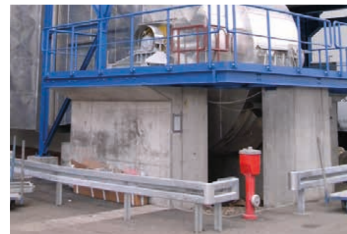
Beispiel für REITZ Retrofit Anlagenbaukompetenz: Fundamentplanung und -bau
