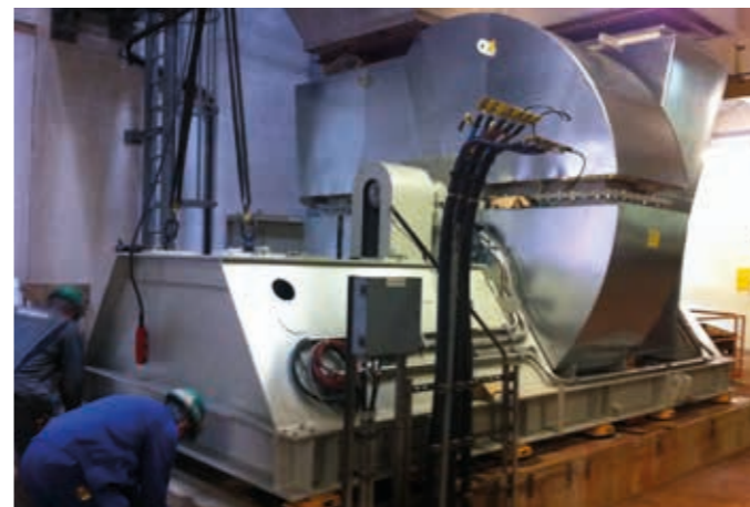
ZAS Burgkirchen , Engineering, Fertigung, Lieferung, De- u. Montage, Austausch des Ventilators
