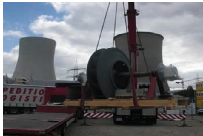
RWE Kraftwerk Lingen , Lieferung, Montage, Inbetriebnahme von vier Ventilatoren
