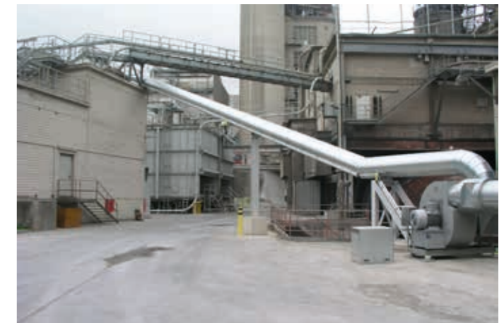
Cemex Zement , Komplettes Abluftsystem mit Ventilator Engineering, Fertigung, Lieferung und Montage einer Abluftleitung mit DN 500 incl. Isolierung
