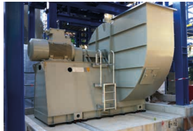
Bayer Dormagen , Engineering, Lieferung, Montage, Inbetriebnahme von zwei Radialventilatoren (ein Reserveventilator) und den erforderlichen Einbauten des Fundamentes inkl. Verfahrensystem
